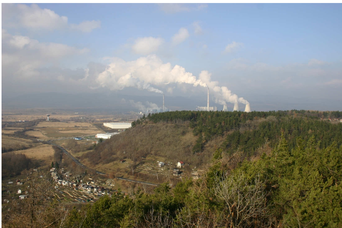
Tepelná elektrárna Prunéřov je od Doupovských hor vzdálena sotva přes kopec (foto O. Peksa)
